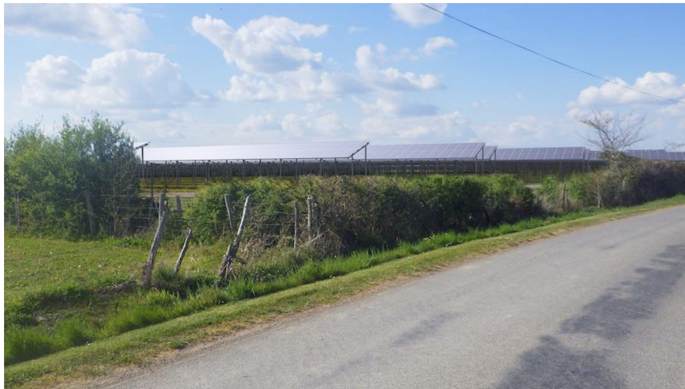
VUE 4 - Vue projetée depuis le Sud du site "hameau de La Jugerie", regardant vers le Nord
